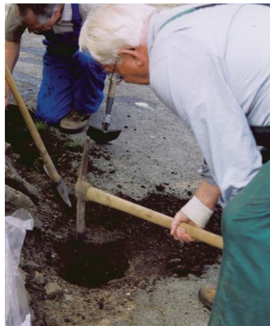
Ausheben der Impflöcher
