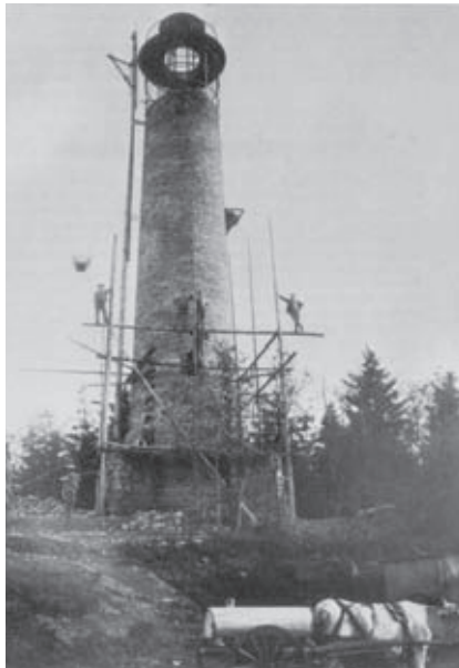
Kindelsbergturm im Rohbau 1906 mit einem einfachen Gerüst und einer Ochsenkarre zum Transport von Baumaterial und Wasser (Foto: Ernst Rothenberg)
